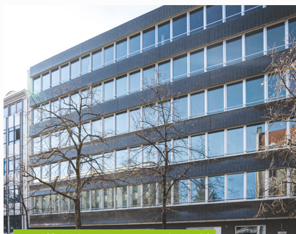
Immeuble H.Trium - Hansastrasse 10 - Munich
