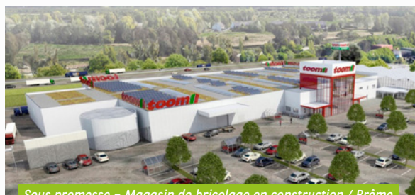
Sous promesse - Magasin de bricolage en construction / Brème
