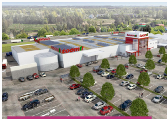
Magasin de bricolage en construction – Brême – Allemagne Livraison prévue au 2 ème trimestre 2023
