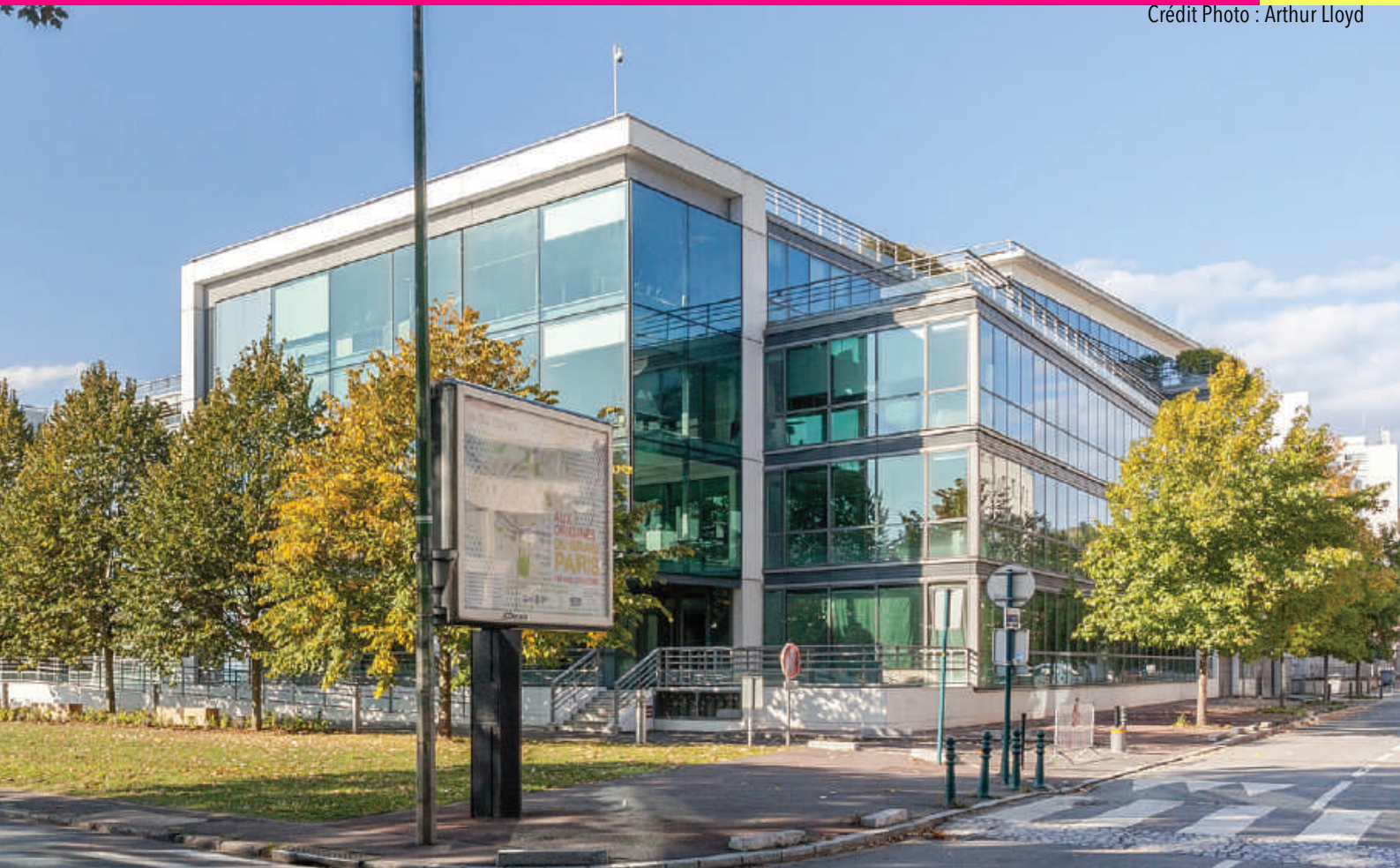
Immeuble « Helys » - Quai Marcel Dassault - Suresnes (92)
