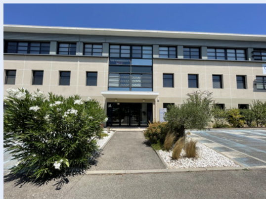
Les Pléiades III - 320 avenue Archimède - Aix-en-Provence (13)
