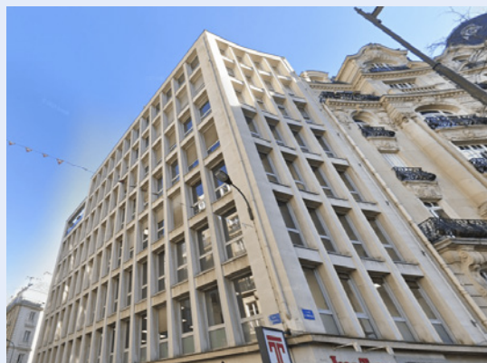
36 Rue Brunel-Paris (17 ème ) - Immeuble
