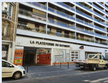
Plateforme du bâtiment - Rue Gros - Paris (16 ème )
