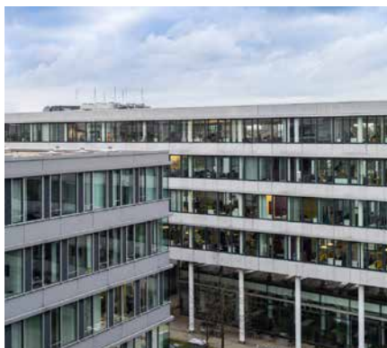
Werinherstrasse 79/81/91 - Munich, Allemagne
