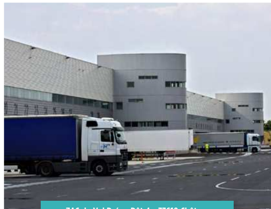
ZAC du Val Bréon Bât 4 - 77610 Châtres
