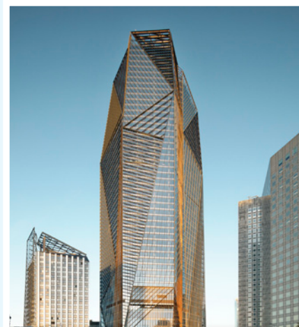
Tour Hekla - La Défense Puteaux (92) Immeuble de bureaux - 76 000 m 2 - 48 étages
