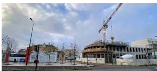
St-Germain-en-Laye- perspective et chantier en cours
