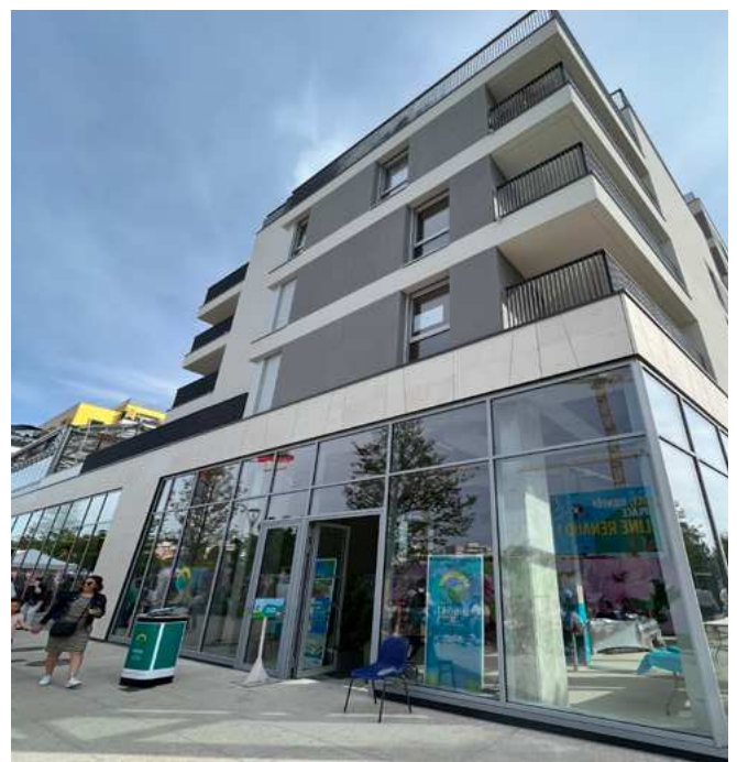
Boulangerie en cours d'installation - Rueil Malmaison
