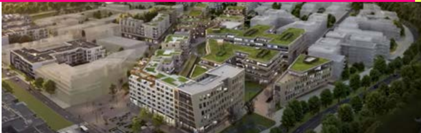
Rue Commerçante à Chatenay-Malabry
