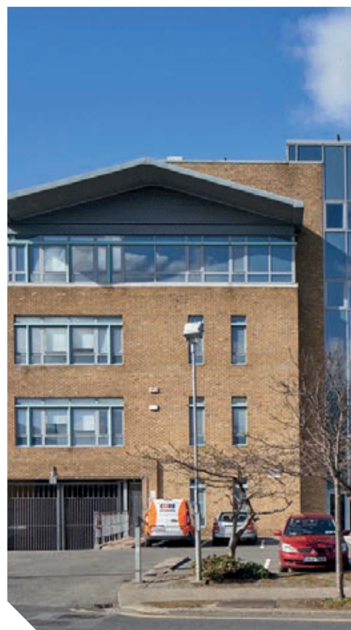
Bureaux Google à Dublin en Irlande, acquis par EURION le 12 mai 2020.
