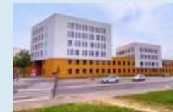
Bureaux et locaux d'activités à Lyon
