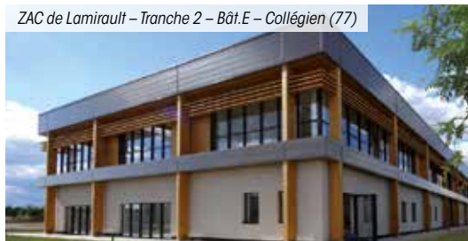
ZAC de Lamirault – Tranche 2 – Bât.E – Collégien (77)
