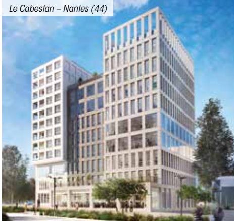
Le Cabestan – Nantes (44)
