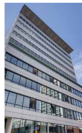
Immeuble de bureaux 23-27 rue Daviel - 75013 Paris Multi-locataires Acquis le 10/02/2022 - 65 M€
