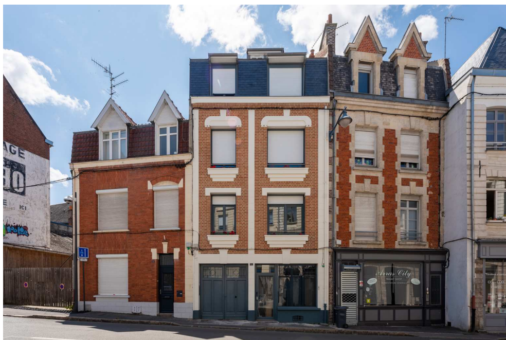
Acquisition #6 - 55 rue des 3 Visages 62000 Arras
