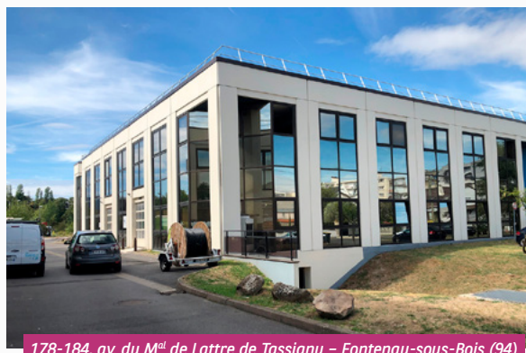
178-184, av. du M al de Lattre de Tassigny - Fontenay-sous-Bois (94)
