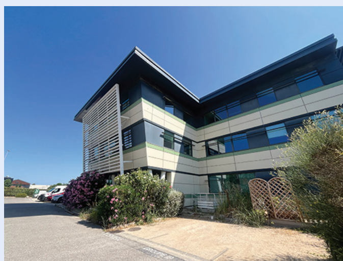
Immeuble de bureaux à Aix-en-Provence (13)
