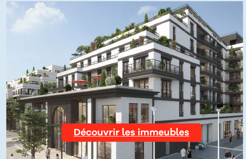
Logements sociaux à Saint-Ouen
