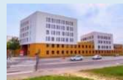
Bureaux et locaux d'activités à Lyon
