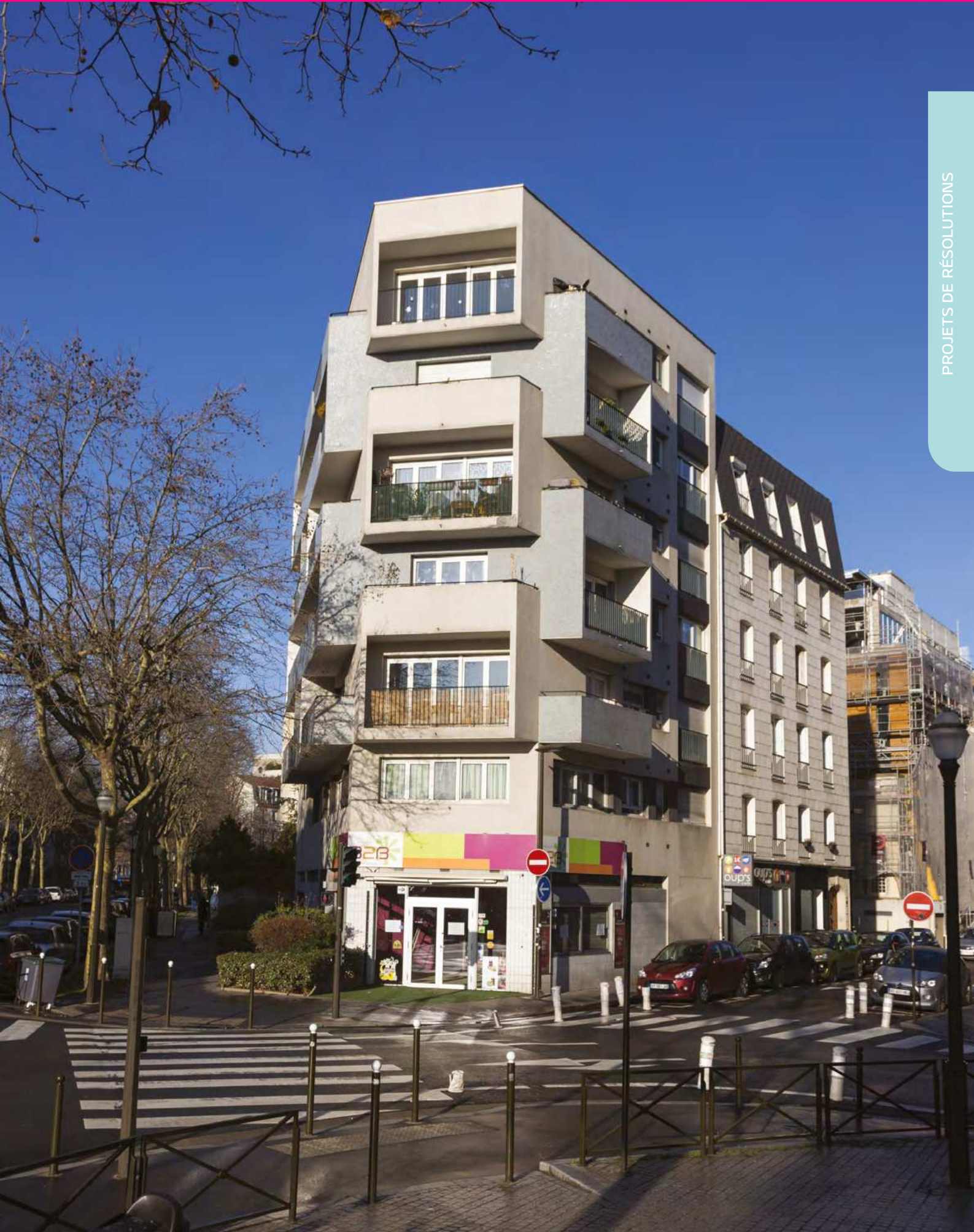
54, AVENUE MORIZET – BOULOGNE-BILLANCOURT (92) Droits photos : Philippe Matsas
