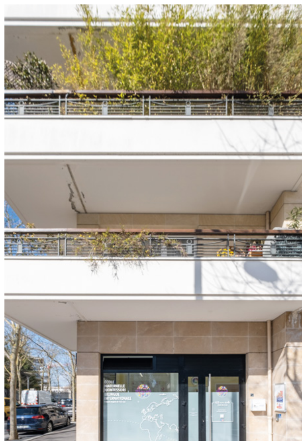
École maternelle en pied d'immeuble - 25-27 bis, rue du Capitaine Guynemer - Bois-Colombes (92)
