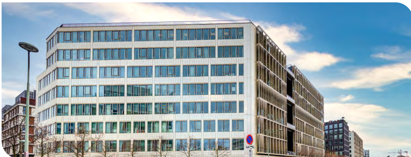
Portefeuille PERIAL O 2 : Immeuble « Gecina »
