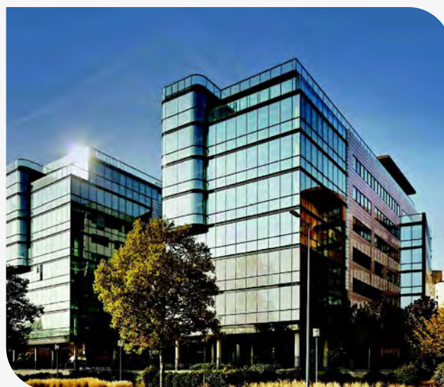
Immeuble « Seine Avenue » - Portefeuille PERIAL Grand Paris
