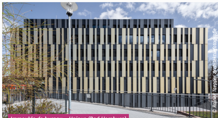
Immeuble de bureau - Uniques (Bad Homburg)
