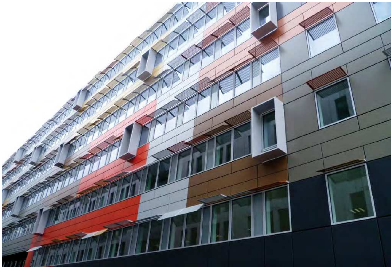
Montreuil (93)- "B Initial" - 7 rue des Longs Quartiers
