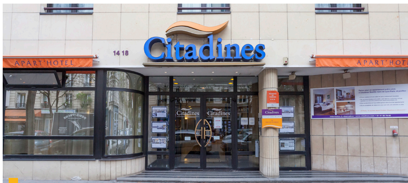
14 - 18 rue de Chaligny à Paris (12 ème )
