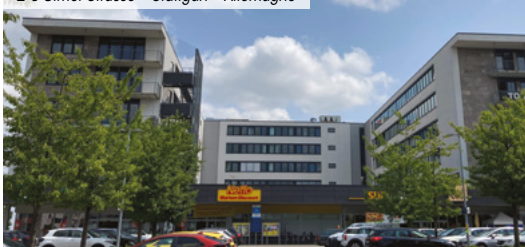
2-6 Ulmer Strasse - Stuttgart - Allemagne
