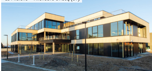
La Pilaterie – Villeneuve-d'Ascq (59)
