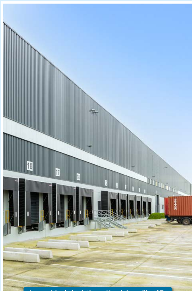
Immeuble de logistique, Heudebouville (27)
