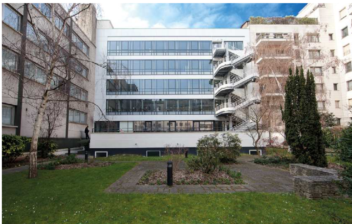
Levallois-Perret (92) - 100-102 rue de Villiers
