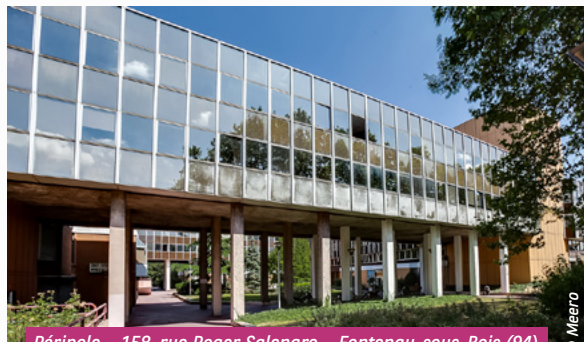
Péripole - 158, rue Roger Salengro - Fontenay-sous-Bois (94) (actif cédé)
