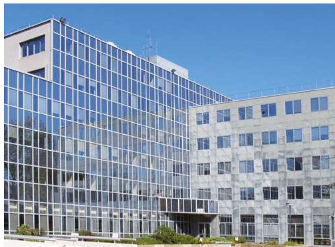
▼ 183, avenue Georges Clémenceau - Nanterre (92)
