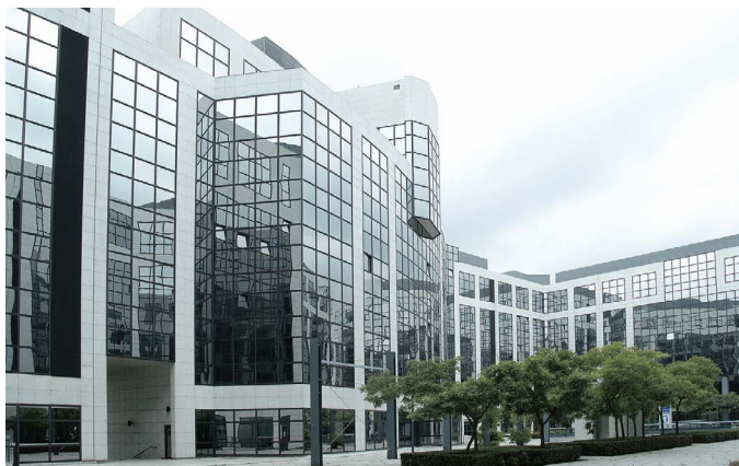
▲ 12, boulevard du Mont d'Est - Noisy le Grand (93)
