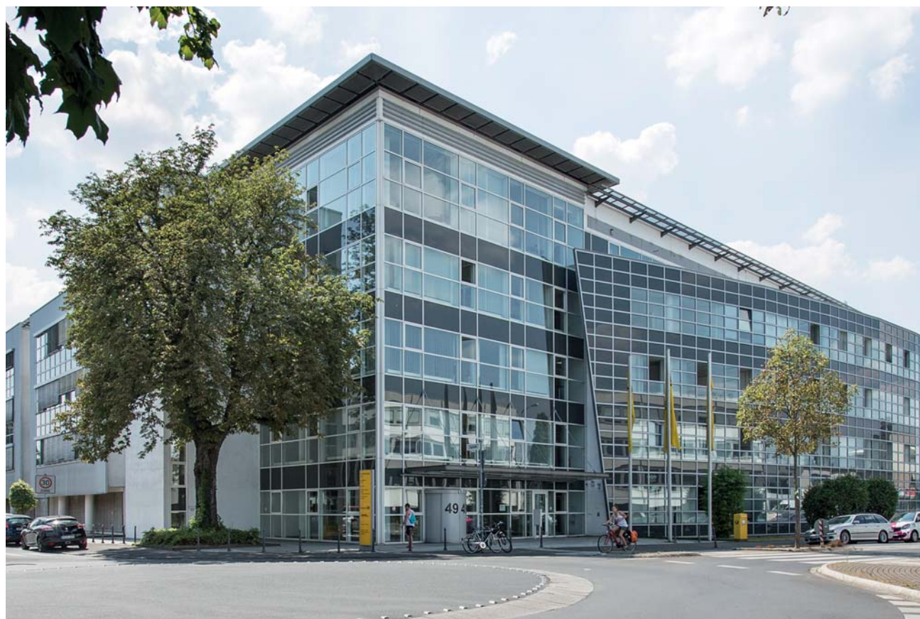
Vorgebirgsstrasse - Bonn (Allemagne) Locataire principal : Deutsche Post Immobilien
