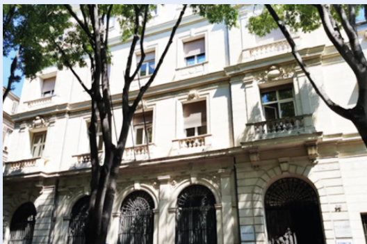
32 Cours Pierre Puget - Marseille
