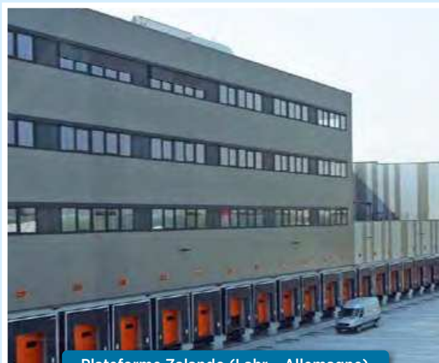
Plateforme Zalando (Lahr – Allemagne)
