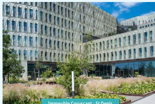
Immeuble Coruscant - St Denis
