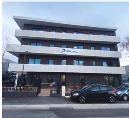
La Canopée – 390 rue C. N. Ledoux – Aix-en-Provence (13)
