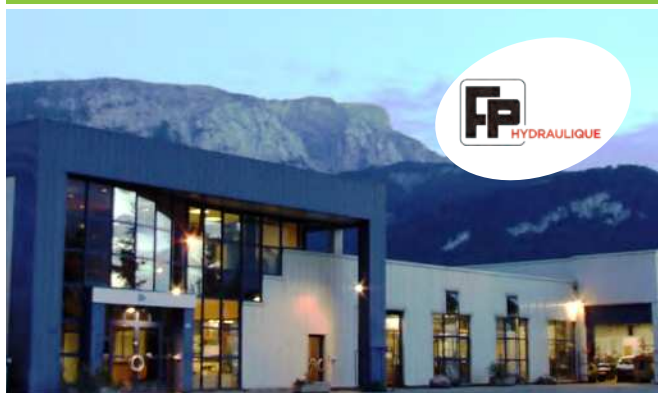
THYEZ // Haute-Savoie 1 825 m 2 de locaux industriels
