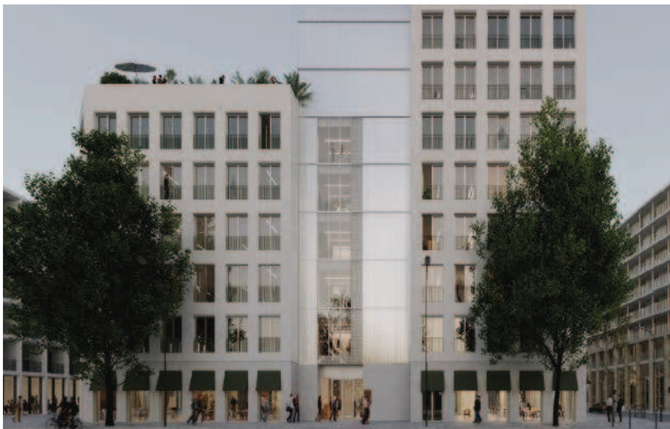
Rue des Marchandises – Ile de Nantes
