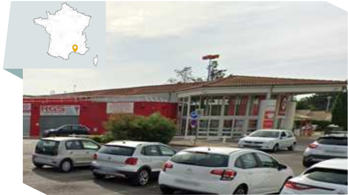
Galerie Saint-Victoret | SAINT VICTORET
