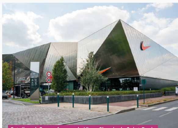
Retail park Enox - Avenue du Vieux Chemin de Saint-Denis Gennevilliers (92)
